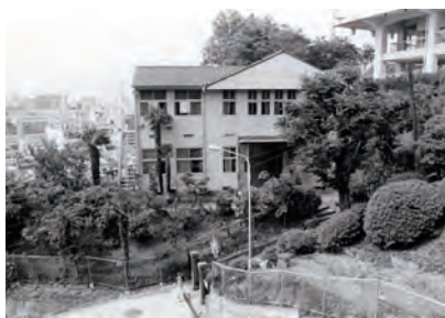
音楽科創設の校舎・旧4号館
